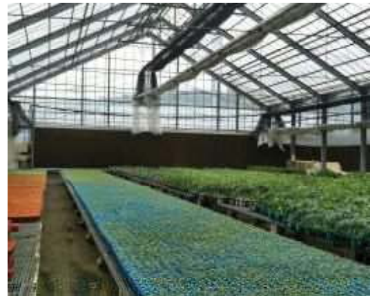
施設の壁面に設置されたパッド このパッド内に水が流れる
